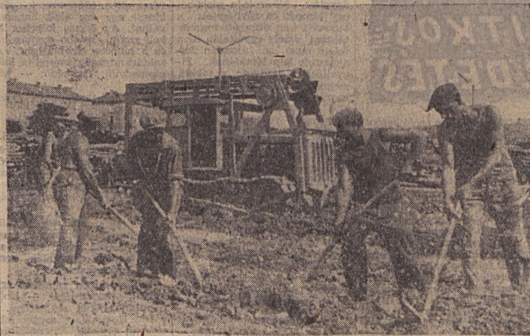
A Hidepítő Vállalat dolgozói nemrégiben kezdték meg a Szénbányászati Tröszt központi faterének tereprendezését, de máris látható munkájuk eredménye: a gatterház mellett simára egyengették és sállal burkolták a terület egy részét, amelyre szinte mértani pontossággal rakták vissza a fa- és deszkamöglyákat. Felvételünk a 7 millió 553 ezer forintos munka egyik mozzanatát mutatja; a nehezebb részt a földgyalú vállalta, a többivel már megbirkózhatnak az emberek is.
