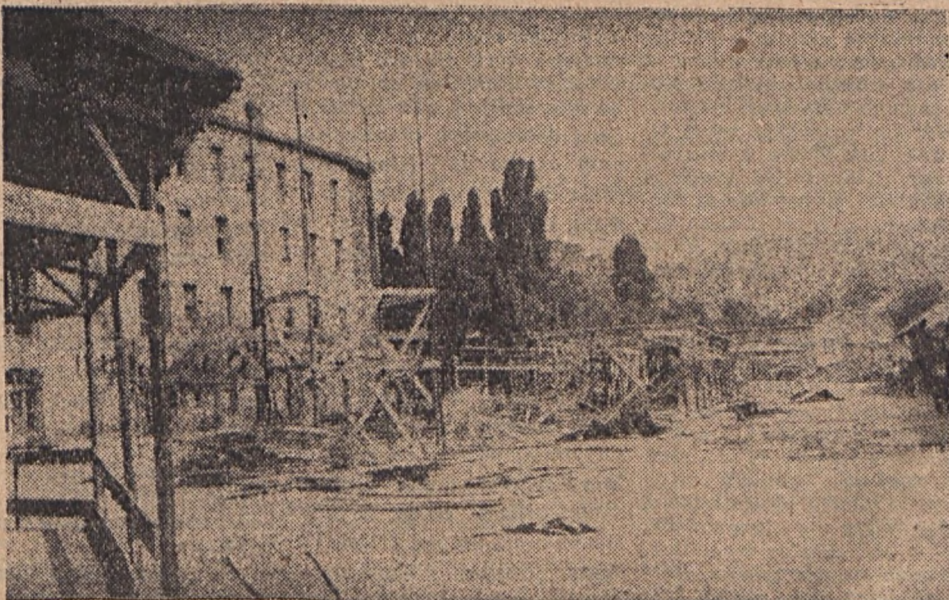
Bejejezéshez közeledik a bányásznapisíri vásárvasáros építése. A pavilonok átadását napokkal ezelőtt megkezdték, most örökíti meg, a következő szá-
