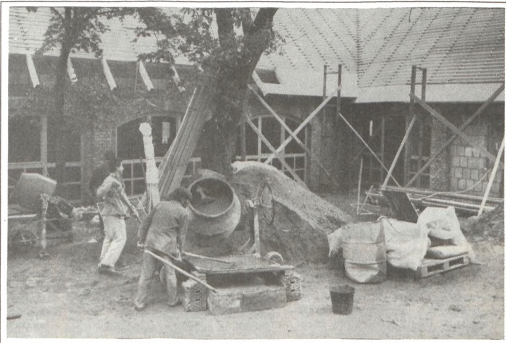
Igazi építkezési csatátér képét mutatta a majdani egészségügyi centrum területe, amikor július közepén ott jártunk. Ekkor már készen álltak a régi épület térkialakításai, a burkolók éppen a csempezést végezték. Ezt a szárnyat szeptember 1-én adják át az építők. Az újszárny ekkor cserepezésre készen állt, ebben december 1-re kell elkészülni. A beruházás ütemére és minőségére id. Büki László felügyel az önkormányzat felkérésére. Az építómunkákat a Pécsvárad Építőipari Kiszövetkezet végzi. A gáz-, víz-, fűtőszelést a pécsi ÉLISZ, a villanszerelést pécsvárad magánvállalkozó készíti el. Képeinken az új épületszárny. (Fotó: Gállos)
