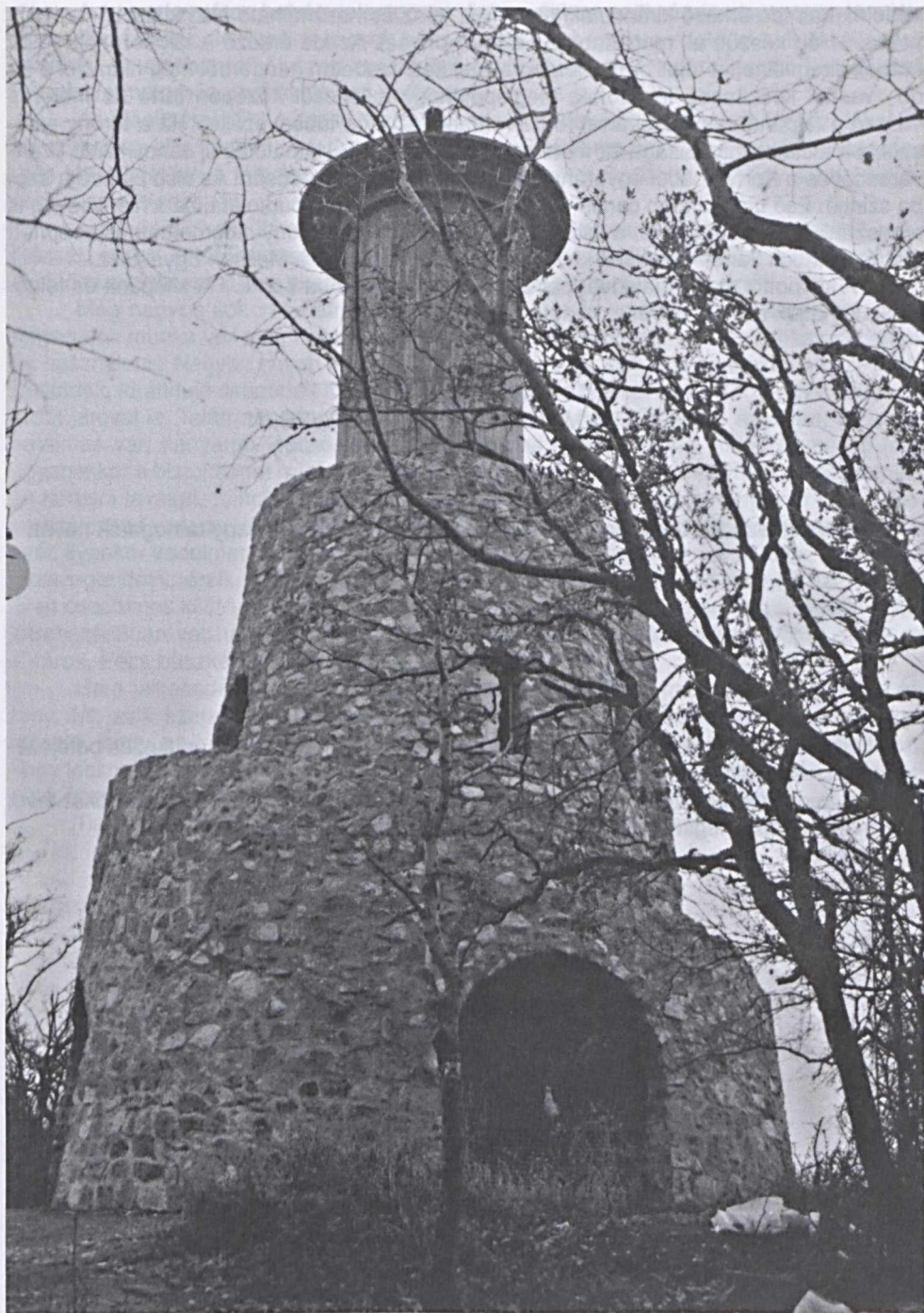
Az újjáépülő Tubes kilátó, 1998-as állapotban
