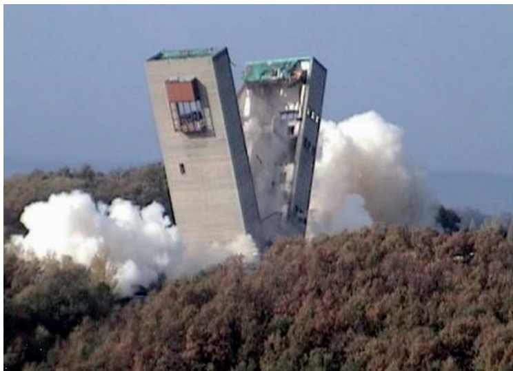
Az V. szállítóakna tornyának robbantással történő bontása
