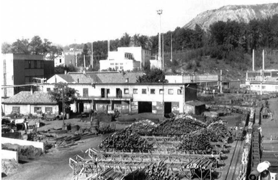
Aknaudvari kép (jobbra a kép előterében az 1970-80-as évek fejlesztései során elkészült gépi mozgatású fatárolókkal ellátott fatelep, balra a K-i aknai gépház, középen egy régi műhelyépület, fenn középen az új transzformátor épület, jobbra fenn a külfejtés magashányója)
