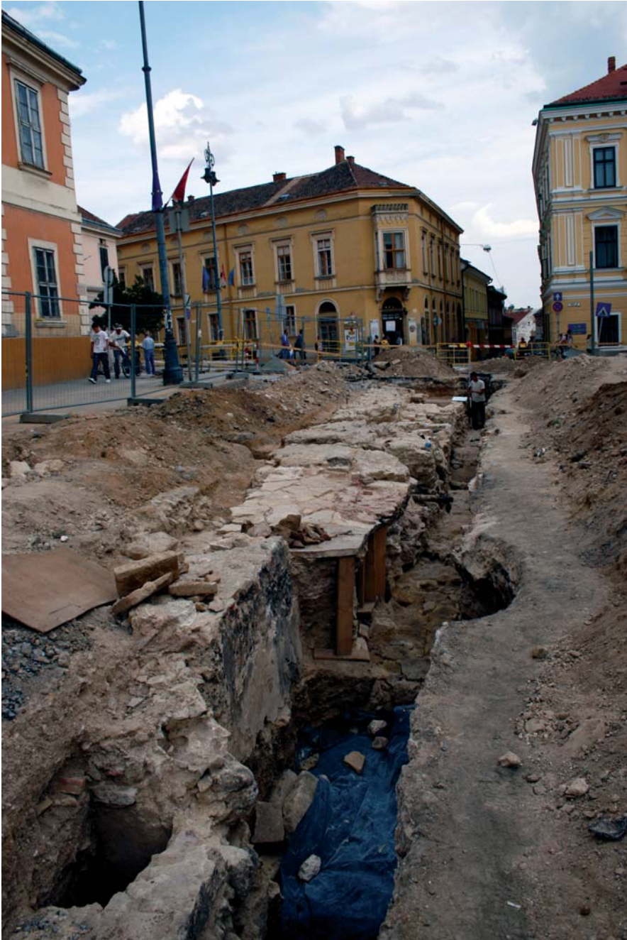
Gázvezeték árka a Szent Benedek templom északi oldalhajójának területén a templom északi falával
