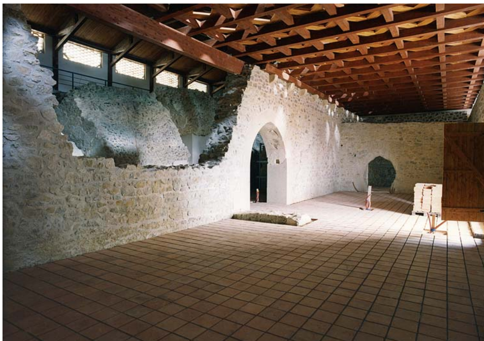
A „Nagyterem” helyreállítás közben.
