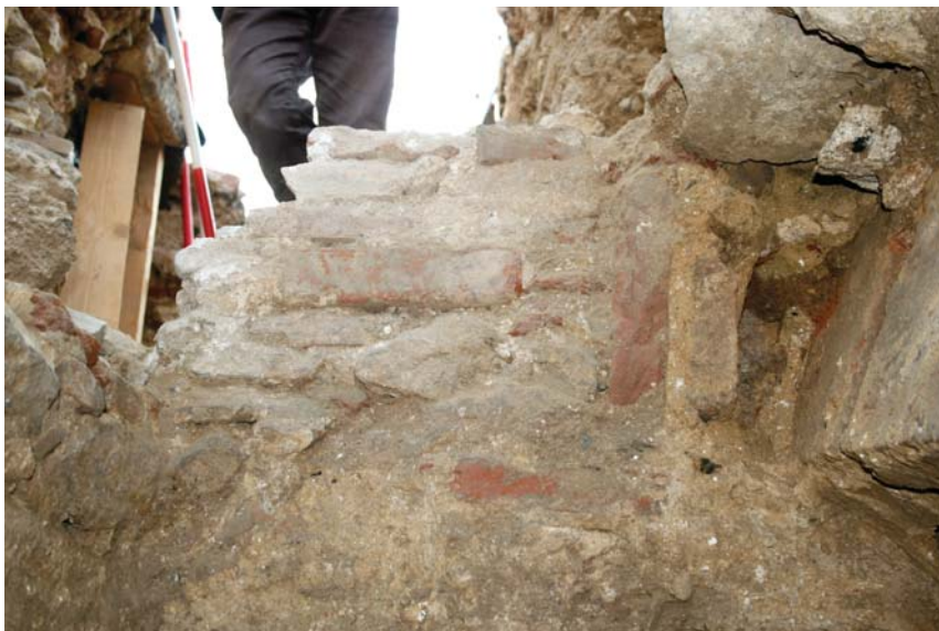
A keleti fal belülről: a visszabontott boltív és a helyére rakott fal
