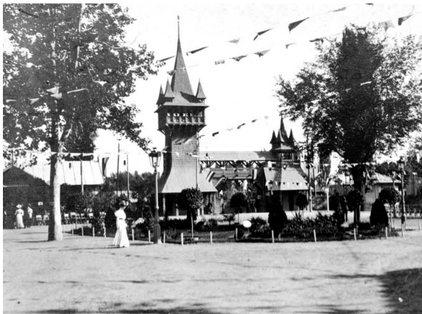
A főbejárat látványa a kiállítás felől
