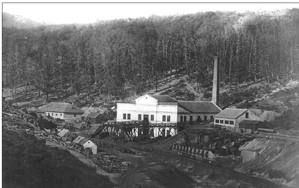
Károly szállítóakna és átrakóállomás a 19. sz. második felében
