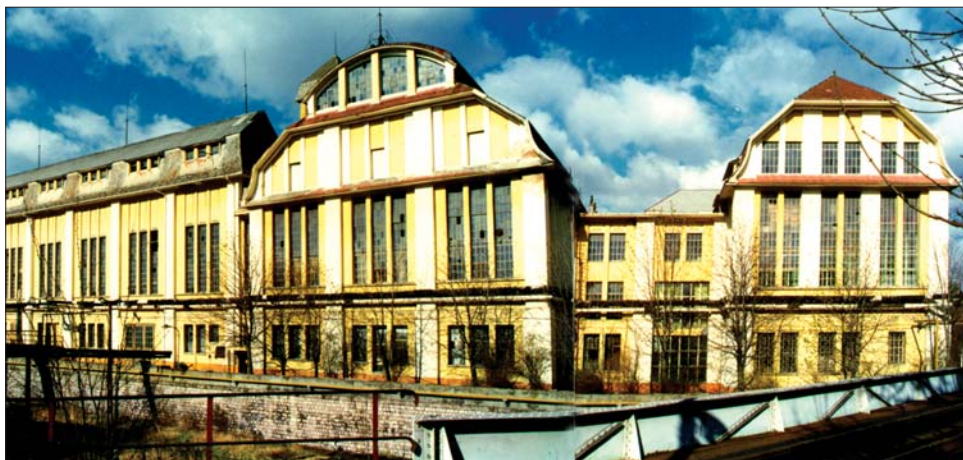
A régi villamos erőmű épülete Pécsújhegyen (fotó: Hübner Mátyás)
