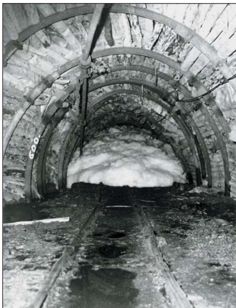
Bányavágatban előrehömpölygő léghab-dugó, a nyílt bányatűzek oltására
