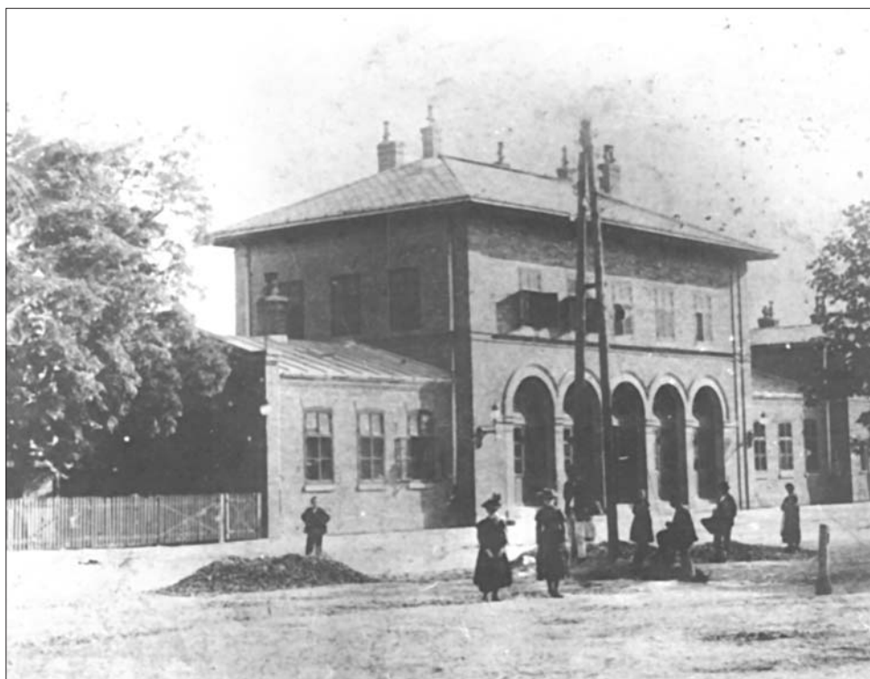
A régi állomás-épület, az Indóház, a 19. sz. végén
