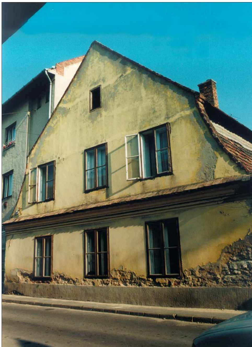
A ház utcai, északi homlokzata
