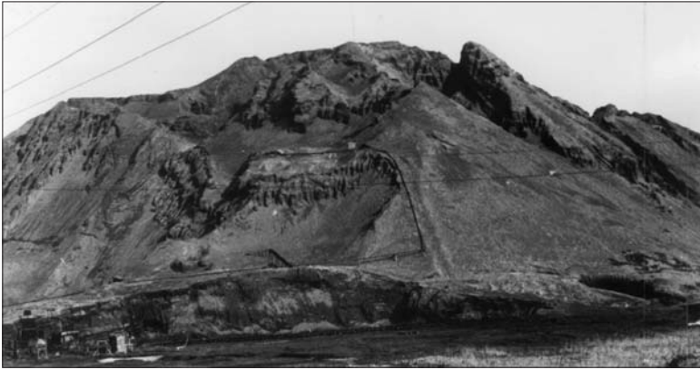
A salak-pernyehányó mosatásakor a nagynyomású vizet a déli oldalon vezették fel
