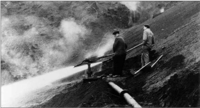
A nagynyomású vizet „monitorok” irányítják
