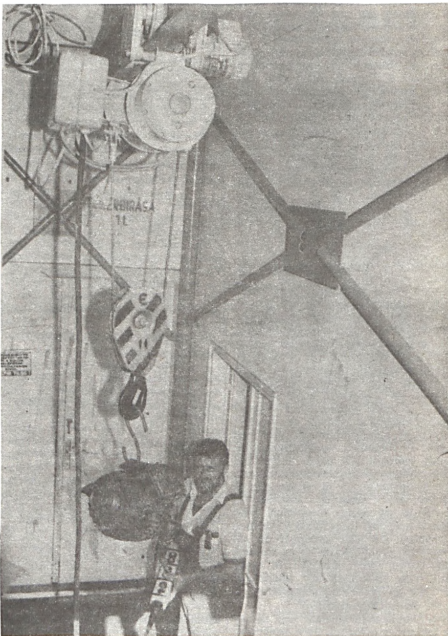
Új szerkezet a nagyobb alkatrészek mozgatására a villanyszerelő-lakatos műhelyekben. Így nagy mértékben csökkent a mozgatás közbeni balesetveszély.
