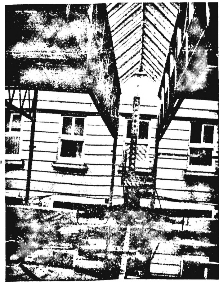
Újabb lépéssel haladt előre az új üzemi csarnok építése. A gyárunk dolgozói által is nagy érdeklődéssel kísért munka jelenlegi szakaszában a vázszerkezetre felkerültek a tetőelemek, s ezekben a napokban a hang- és hőszigetelési munkákat csinálják.
