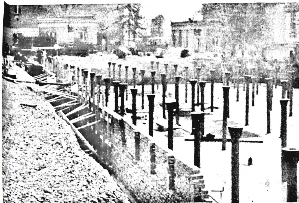
16. Ütemben halad az új csarnok építése, s már állnak a fő tartóoszlopok.
