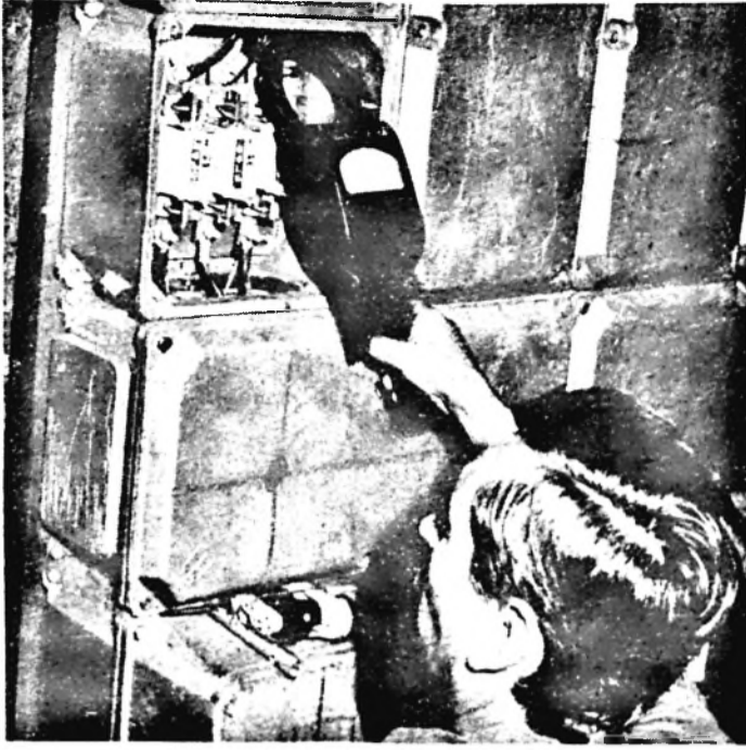
Ellenőrzik a gépi berendezések áramfelvételét
