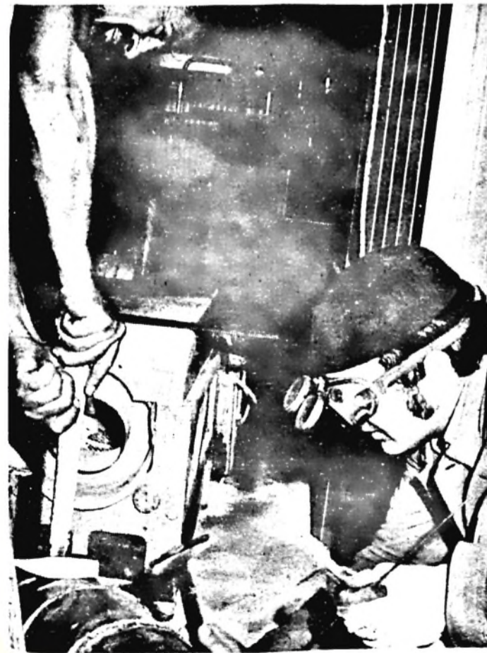
Javítják a csővezeték szigetelését
