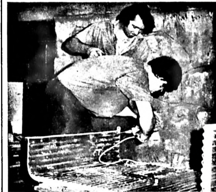
A készáruszállító konveyort is felújították. Képünkön Szeitz Lajos és Schifrik János a védőkosarakat szerelik.
