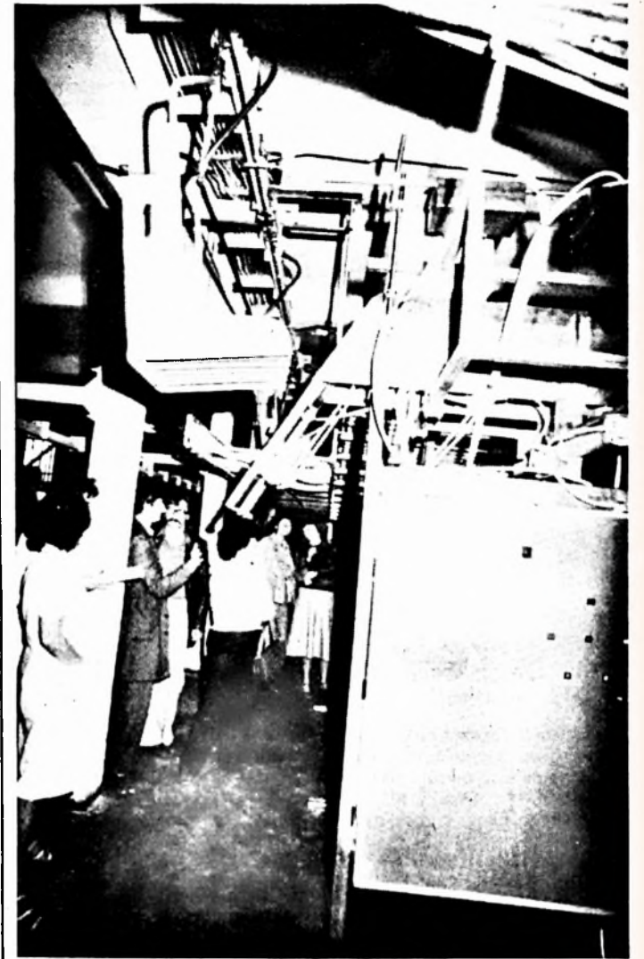
A közelmúltban MÉTE-ankétot rendeztek gyárunkban. Az előadások mellett a résztvevők a gyakorlati tapasztalatokkal is gazdagodtak. Képünkön az anket résztvevői működés közben szemlélik meg az új, automatikus kartonszedő gépet, amelynek tervezését és kivitelezését a gyár műszaki dolgozói végezték. Az anketra következő számunkban térünk vissza.
