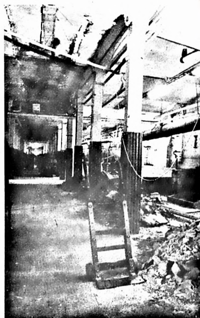
Megkezdődött az előkészítés korszerűsítése. A munkáról képriportban számolunk be a 3. oldalon.
