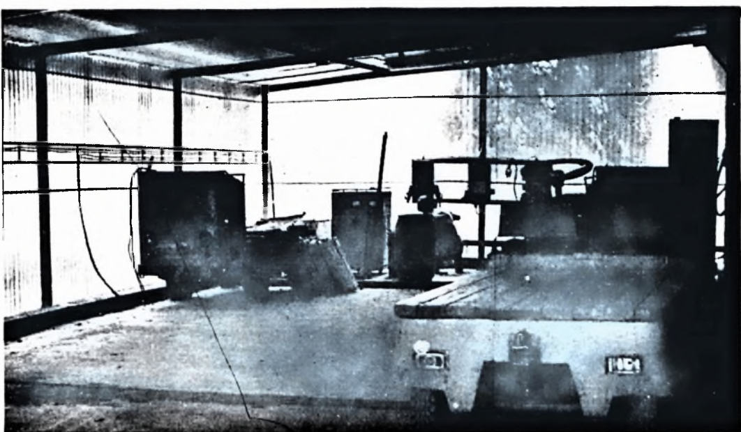
A III. számú raktár területének jobb kihasználása érdekében szükség volt az anyagmozgatásban használt targoncák kitéleltetésére. Az elmúlt hetekben új villamostargonca-garázst és töltőhelyet alakítottunk ki. A fedett területen könnyebb a targoncák javítása, karbantartása, a töltőkészülékek kihasználása, s a korábbinál nagyobb alapterület áll rendelkezésre.
