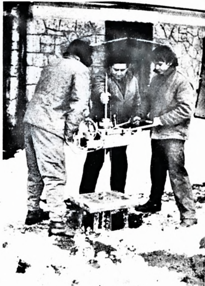
Az AGROBER szakemberei az előkészítés rekonstrukciójával összefüggő próbafúrásokat végzik gyárunk udvarán
