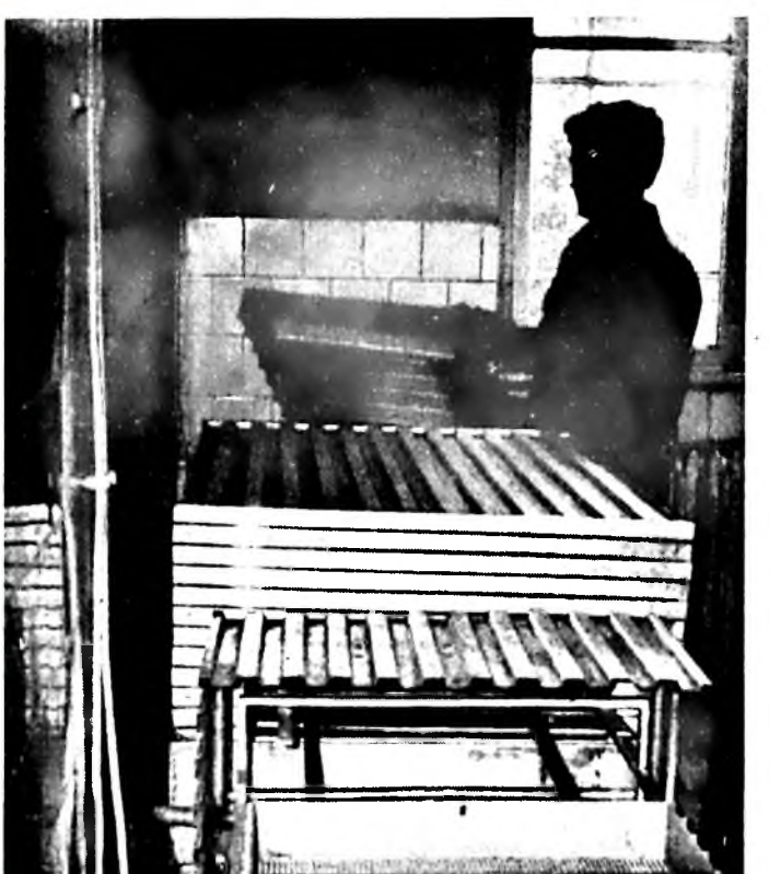
Elkészült és a közelmúltban üzembehelyezték vállalatunknál, a tartályosó berendezést
