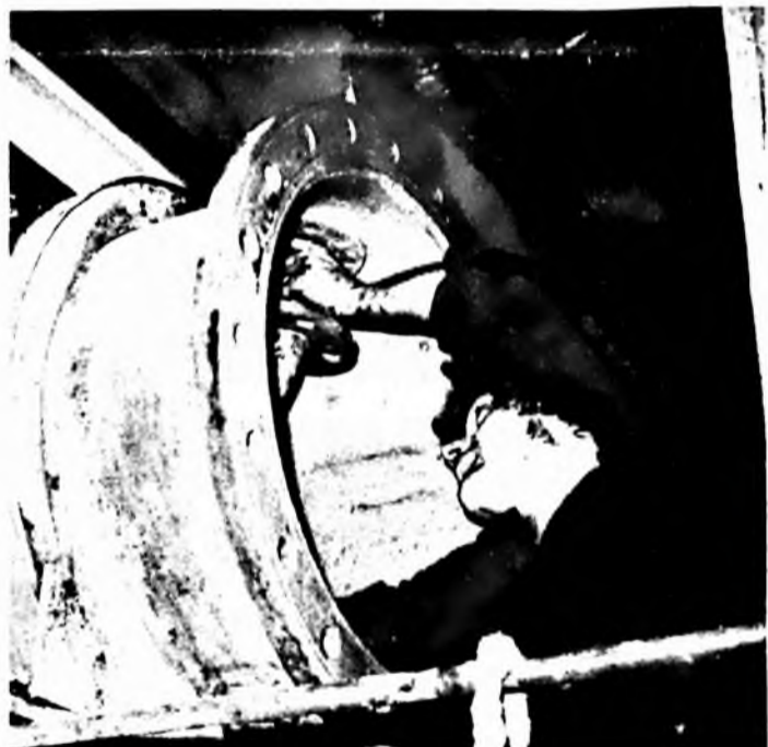
Neszemény László a vákuumkamra javítása közben
