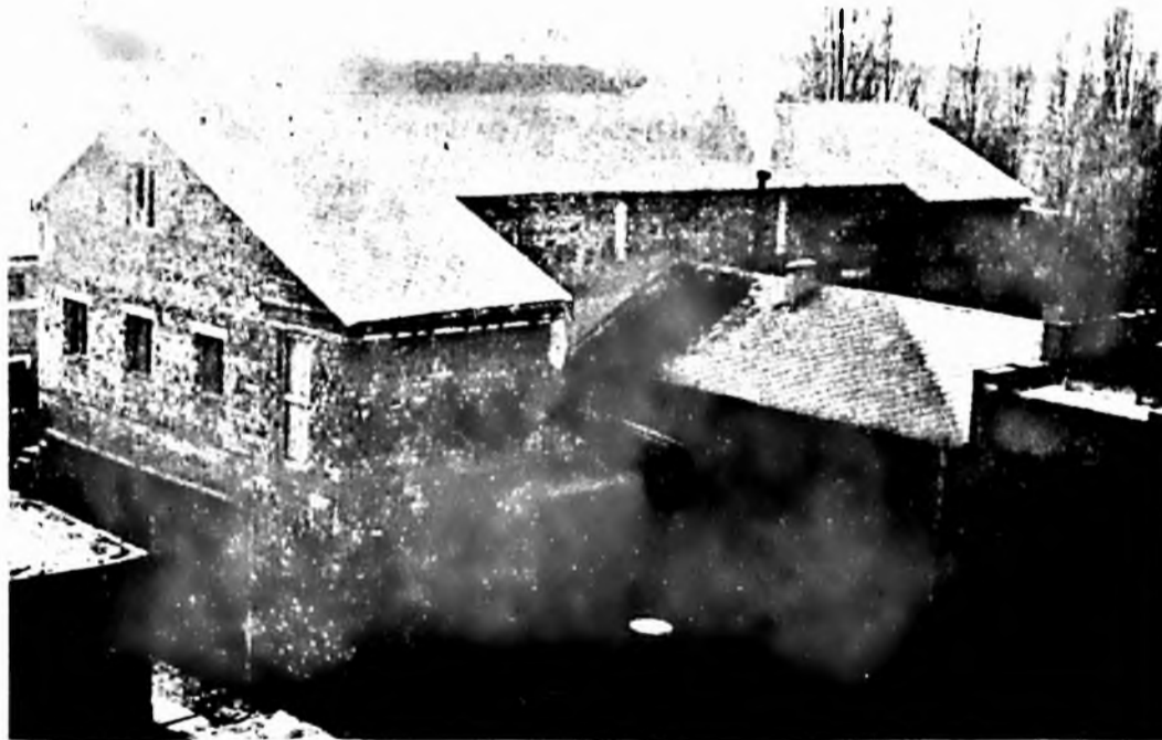
Az év végére tető alá került a felújított, illetve bővített gyári öltöző- és fürdőépület
