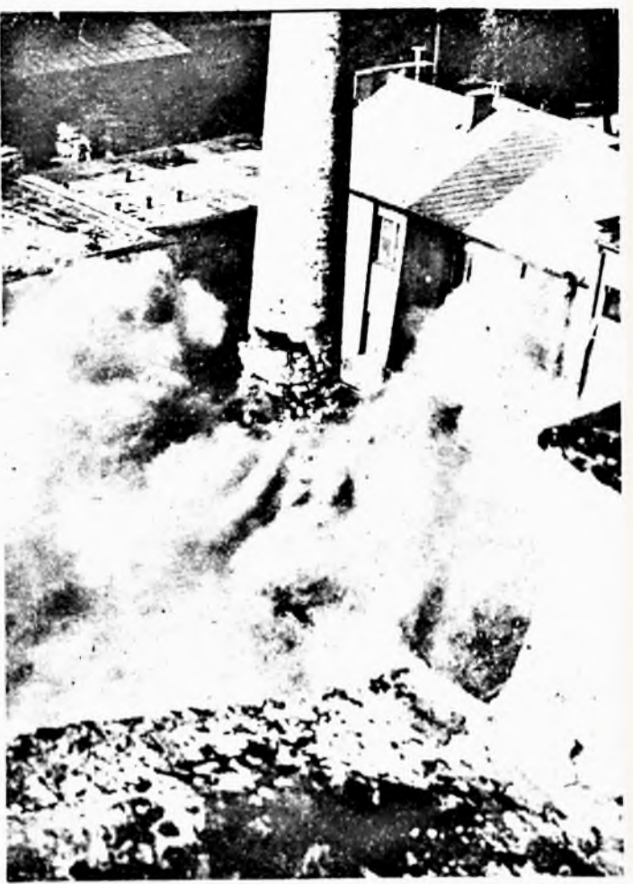
Hatvanöt éves szolgálat után magába roskadt gyárunk hőközpontjának kiszolgált kéménye. Az utóbbi években már nem ergettett bodor füstöt: az öreg kéményt, a Mecseki Ércbányászati Vállalat robbantó brigádja „terítette le” a közelmúltban.
