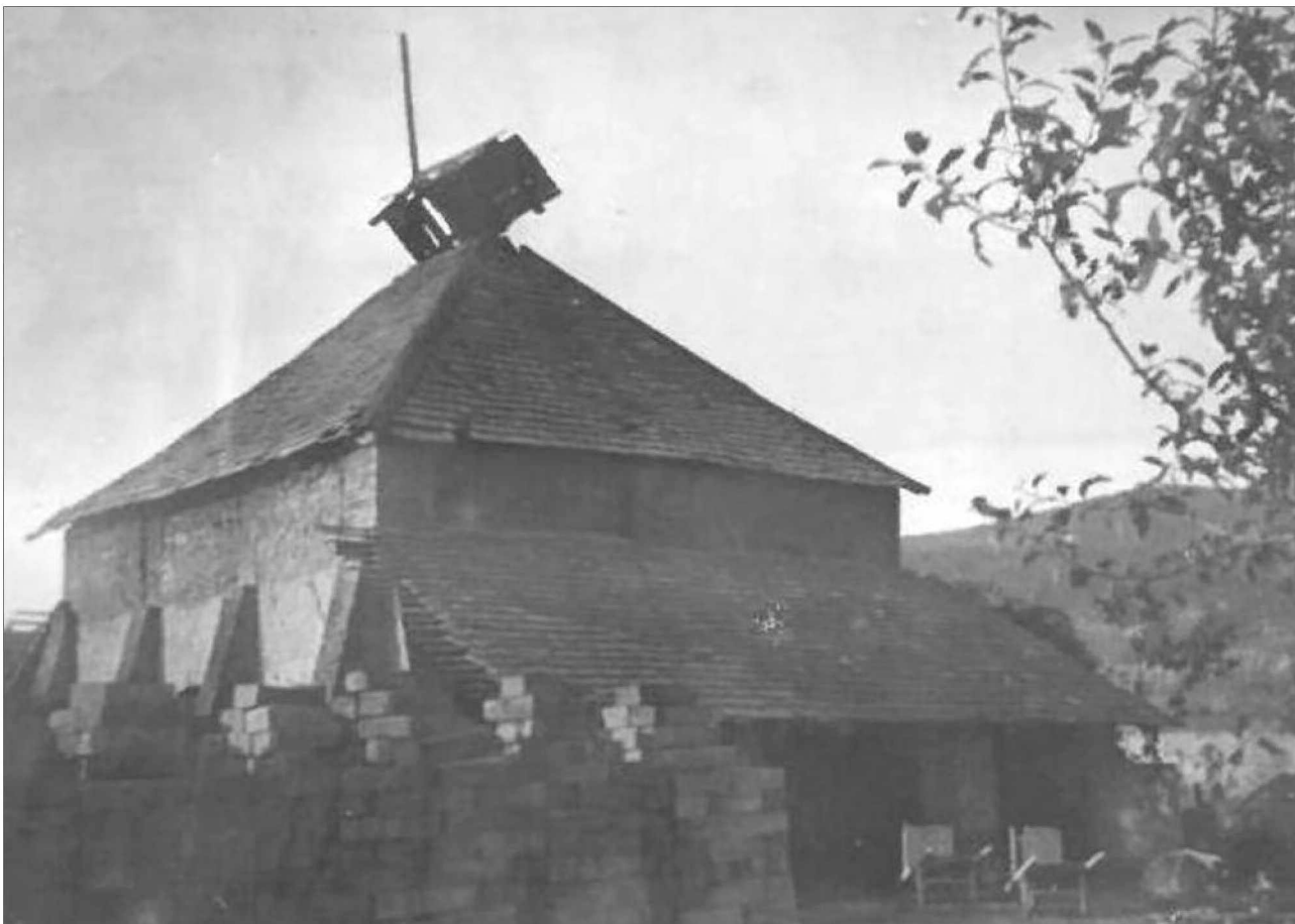
Az egykori téglaház, a Bocz család téглаégetője. A ma már nem látható épület helyén tsz major létesült. Ma magángazdaság.
