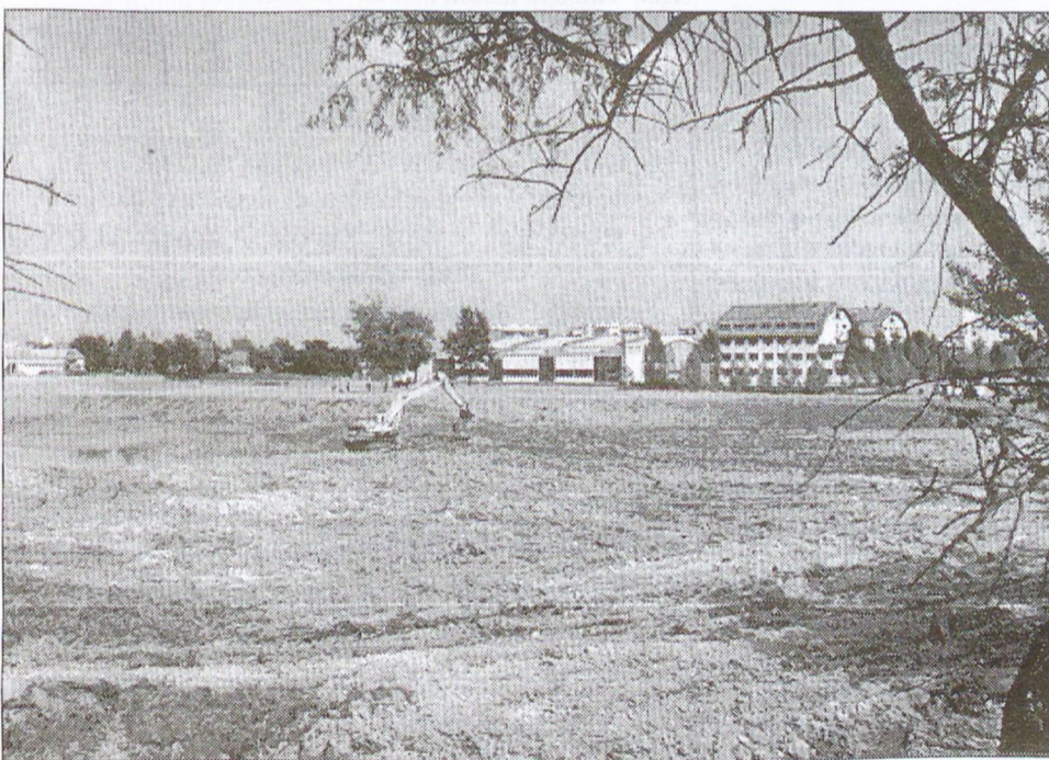
A Sportesarnok melletti téglagyári gödörben megkezdődött a rekonstrukció, készül a Dísztó.
