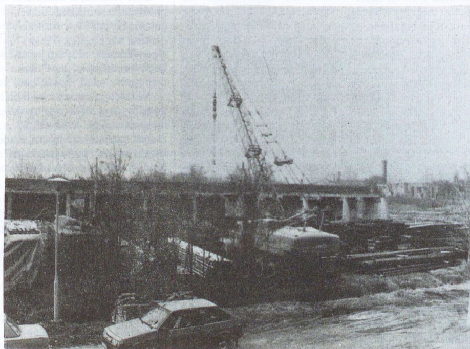
Megkezdődtek a Sportcsarnok vasszerkezetének beépítési munkálatai. Fotó: Schindl
