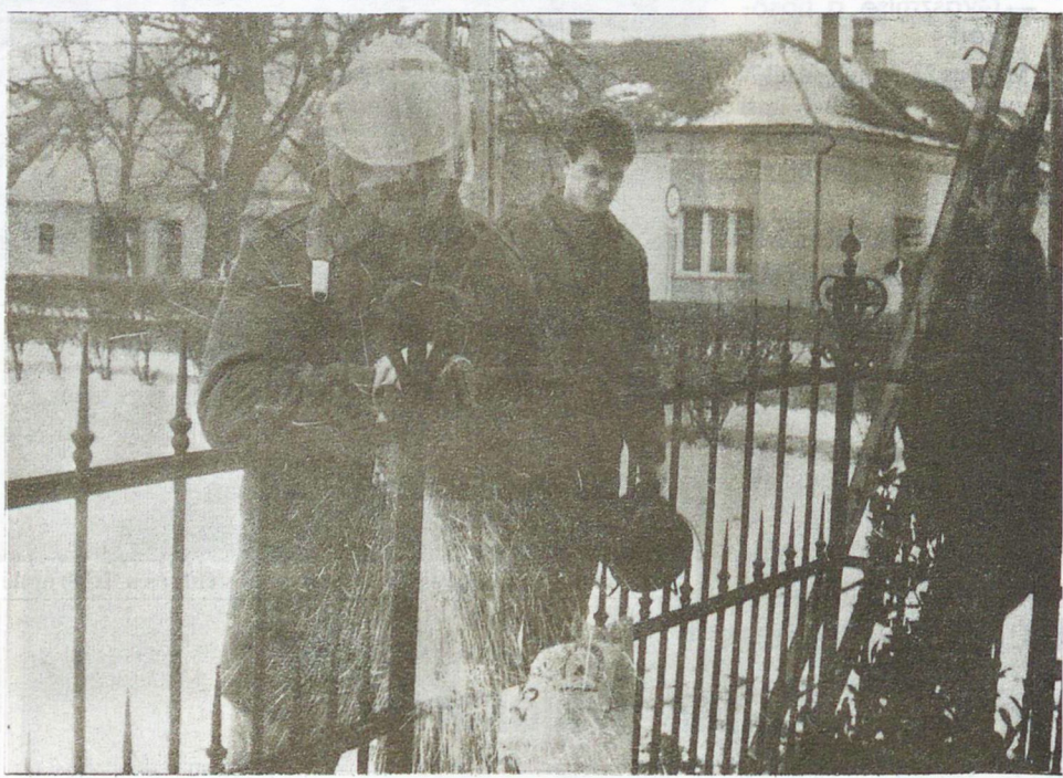
A tűzoltóság végzi a Flórián szobor talapatának és kerítésének felújítását. Képviselet szétszedik és elszállítják a felújításra váró kovacsoltvas kerítést. Fotó: Schindl
