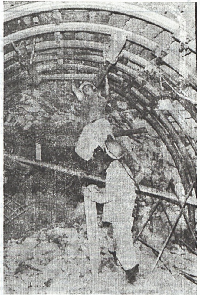
Fábián Károly vájár és Fleischmann Zsolt szakvezető vágatbővítést végez. (Cikkünk a 3. oldalon.) Csördör László felvétele
