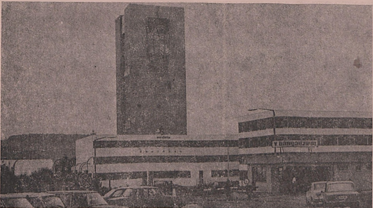
A vállalat 7,5 milliárd forint bruttó és 4,3 milliárd forint nettó állóeszköz állományából a termelés leállításánál 1,5 milliárd forint bruttó, ill. 1 milliárd forint nettó értékű épületet, gépeket és berendezést hasznosíthatunk.
