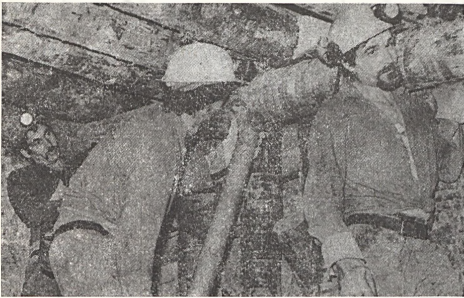
Képközpön balról Hegedűs Ferenc csapatvezető vájár, Nagy Gyula csillés és Hantosi János szakvezető vájár járomácsolat beépítését végzik.
