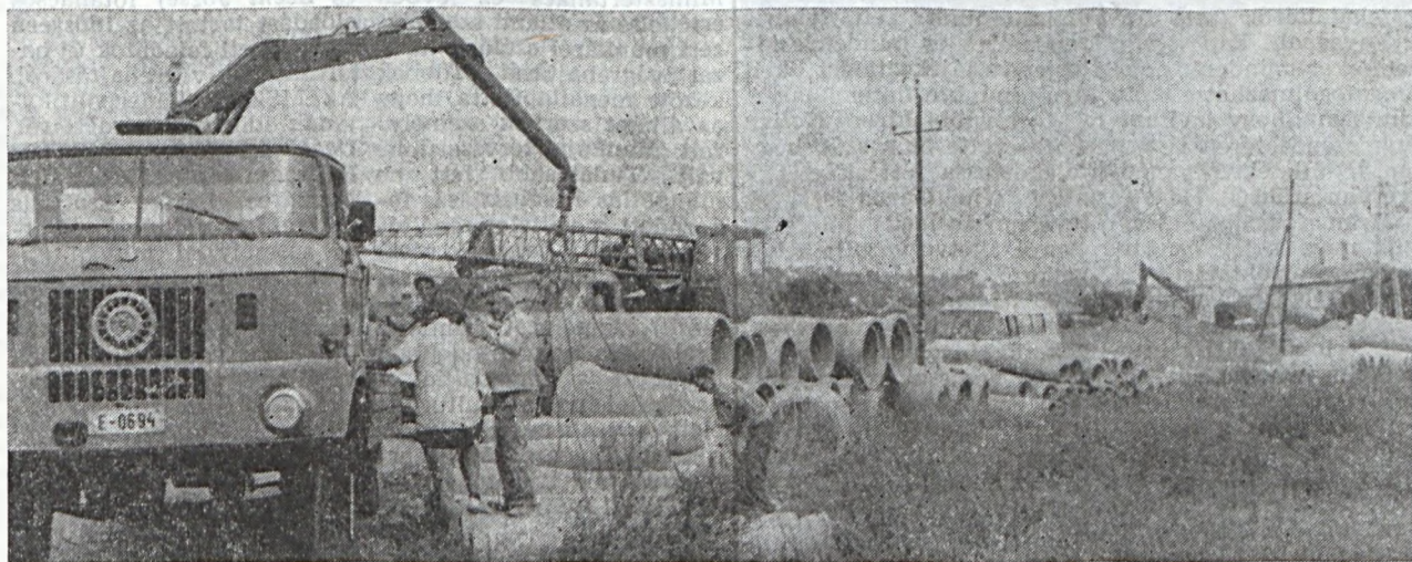
Patacs nyugati területén már megkezdődött a közművesítés.
