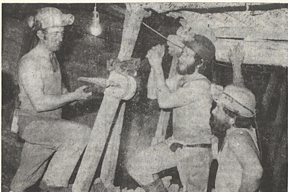
A 67-es csapat a szabadszéli kamrában a kirobbantott tákok visszarakását végzi. A képen balról jobbra: Frey József vágár, János Pál vágár és Klaj Sándor szakvezető vágár látható. Bálint Jenő felvétele
