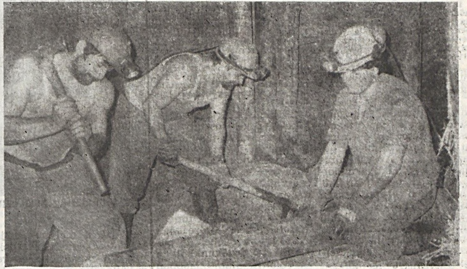
A 7-es csapat tagjai (balról jobbra): Végh László vágár, Balogh Sámuel csapatvezető és Csorba György csillás a faácsolat előkészítését végzik a biztosításhoz. Csöndör László felvétele
