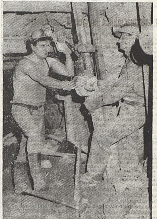
Imre János csapatvezető és Túrós János segédvājár a járomácsolat beépítését végzi.
