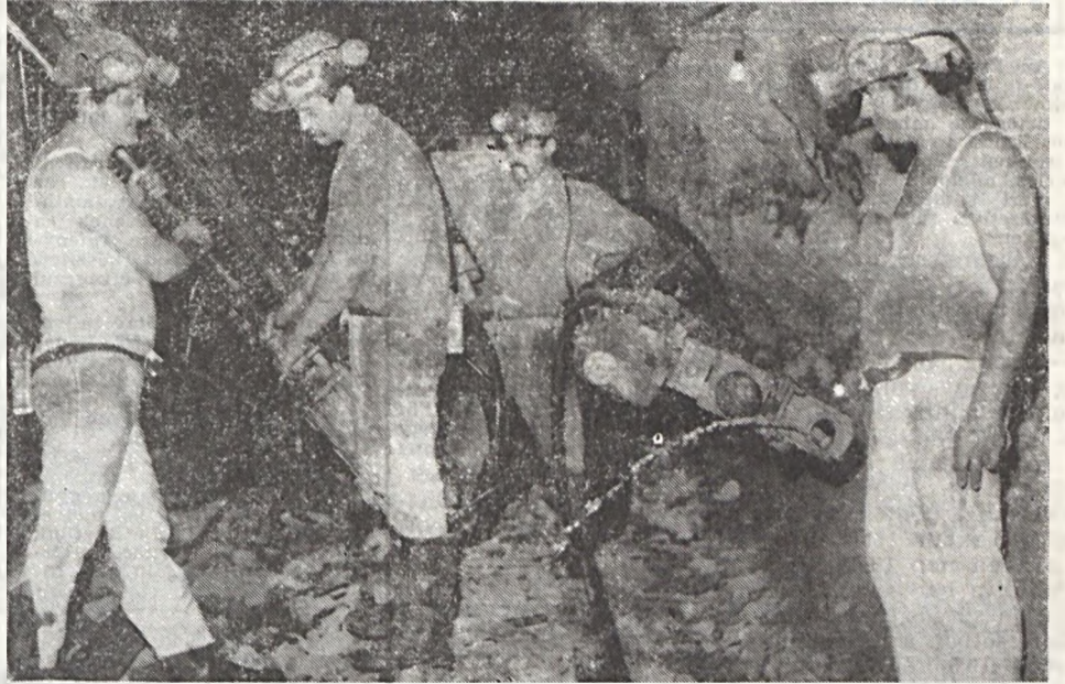
A csapat a vágaton a szegecslyukak fúrását végzi. A képen balról jobbra: Gugora Antal csapatvezető vájár, Öry Attila vájár, Illés József csillás és Baráth Tibor szakvezető vájár látható. Bálint Jenő felvétele
