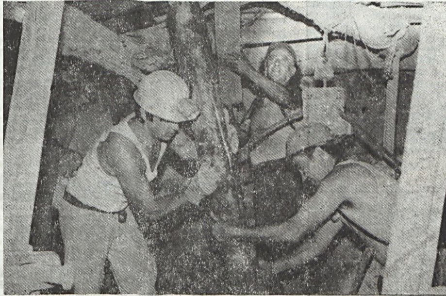
A rablás megkezdése előtt az elágazás biztosítását végzik. A képen balról jobbra: Takács István csoportvezető vájár, Czirják Mihály csoportvezető vájár és Völgyi Sándor segédvájár láthatók.
