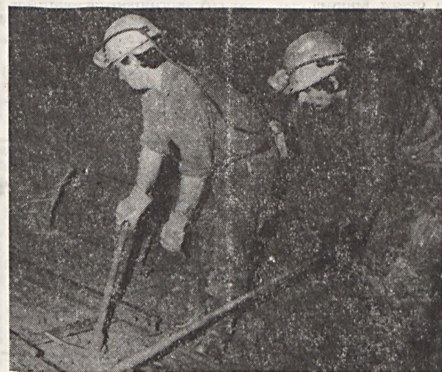
Lajkó Ferenc csillás és Unferdorber Ferenc szakvezető vágátépítés közben.
