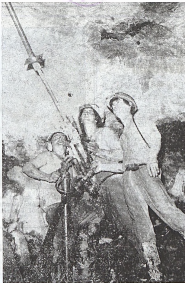
A II. sz. bányüzemi 55-ös csapat szegecsbiztosítás beépítését végzi. A képen balról Nagy Márton csapatvezető vajúr, Mohácsi József csillás és Ceglédi László csillás láthatók (cikkünk a 3. oldalon).
