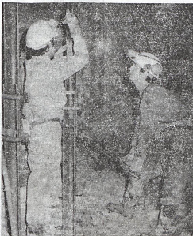
Amit a GHH nyergéből nem lehet csinálni. Tóth József csillés és Sipos György szakvezető a TH-biztosítás beépítését végzi. Berényi Tamás felvétele
