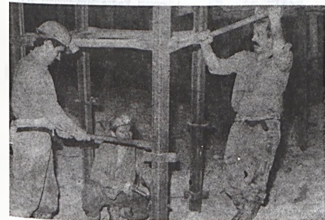
Hegedüs György csapatvezető vajúr, Novák Árpád vajúr, Csirke Dezső vajúr TH-pillér beépítését végzik. Csöndör László felvétele
