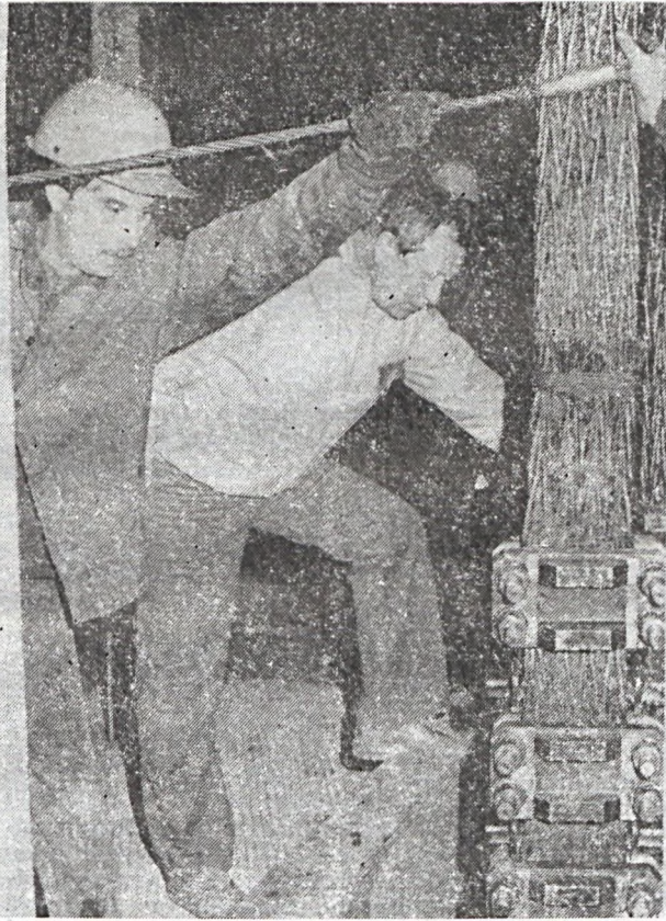
Felvételünkön az I-es szállító gép ellensúlykötél cseréjét végzik. Balról Lucza Péter OBV-szerelő csoportvezető és Káldi Lajos művezető láthatók.
