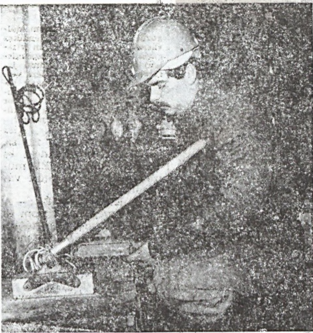
Lovas Andor leszállás előtt a falmérő műszert hitelesíti az ércecs etalonon. Bálint Jenő felvétele
