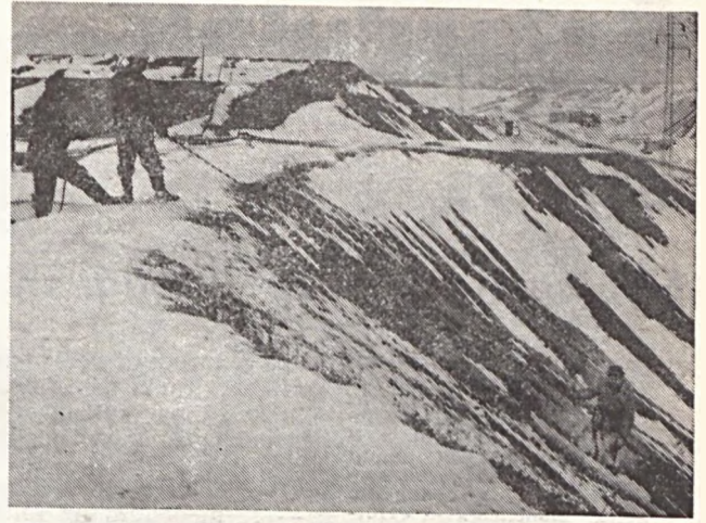
Bódis József, Ferencz István és Egédi Zoltán veszélyes munkát végez a lefagyott túlfolyó cső cseréjénél. Füzy Tibor felvétele
