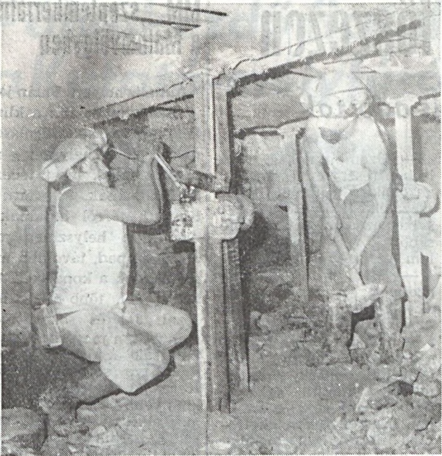
A kirobbantott középtápot építi vissza Dudás Vince csapatvezető vājár (balról) és Hargitai Gusztáv csillás.
