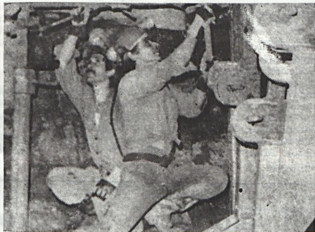
Ácsolás közben a 4. sz. csapat.
