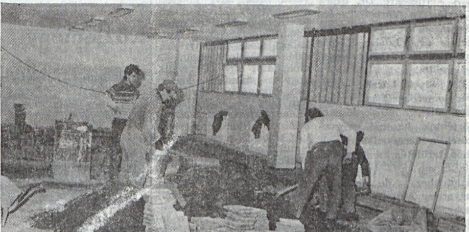
Az építők a fehér öltöző hidegburkolatát készítik.
