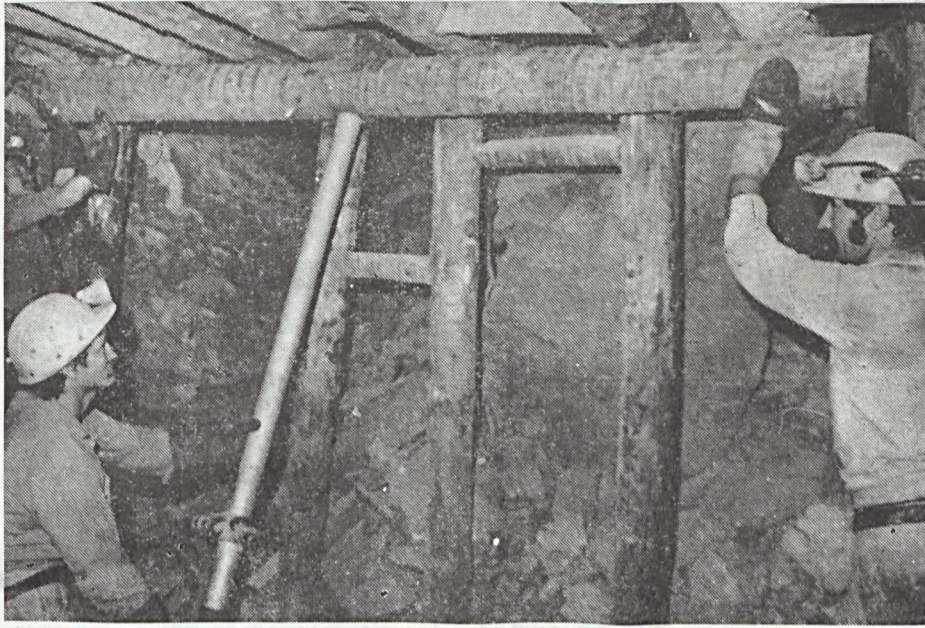
A csapat a járomácsolat beépítését végzi
